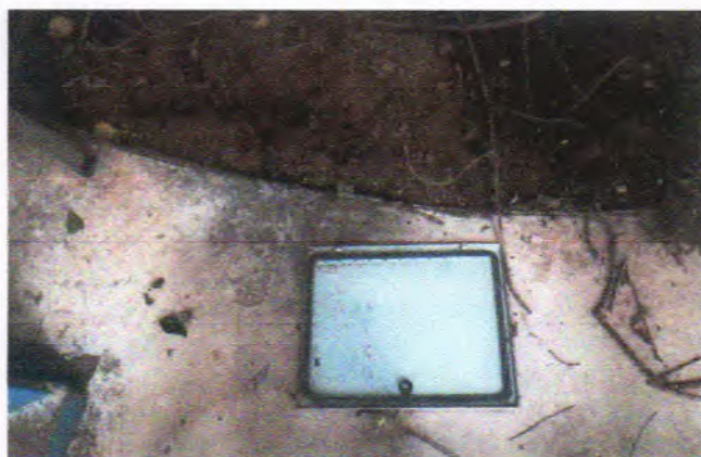
Figura 2. Tampa arrancada da caixa hermética que abriga os equipamentos, localizada acima da caixa d'água.
