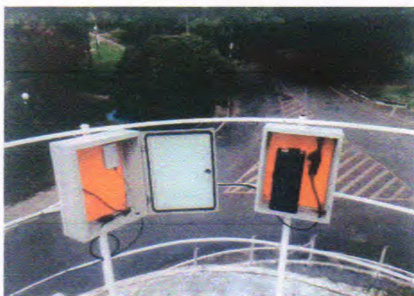
Figura 3. Caixas herméticas abertas com equipamentos revirados e em uma delas nota-se a falta da tampa.
