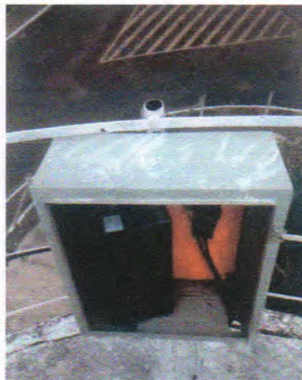
Figura 4. Nesta foto pode-se verificar a falta de pinos das dobradiças, que foram arrancados para a retirada da porta, e também uma tinta branca sobre as caixas.
