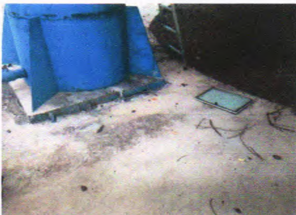
Figura 1. Pode-se notar a tampa da caixa hermética onde abriga os equipamentos no chão da caixa d'água.
