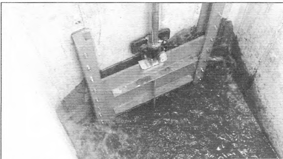
Descrição: Caixa de Fluxo 1 - vazamento na comporta do extravasor.
