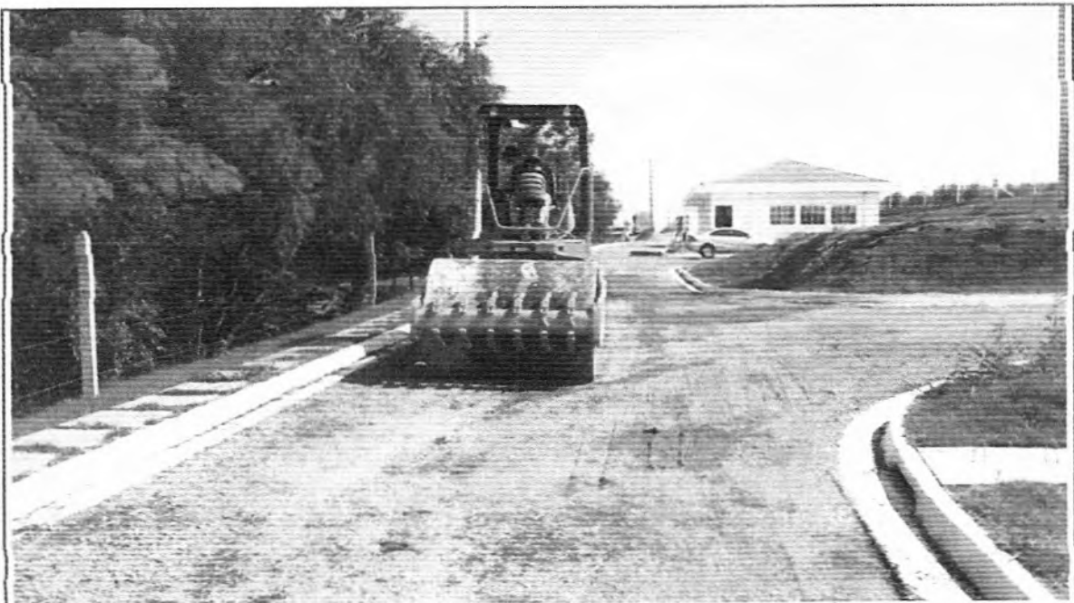
Descrição: Compactação da pavimentação (BGS) das ruas da ETE.
