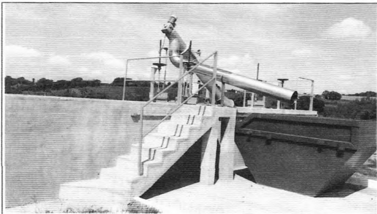
Descrição: Instalação do guarda corpo na escada do Desarenador.
