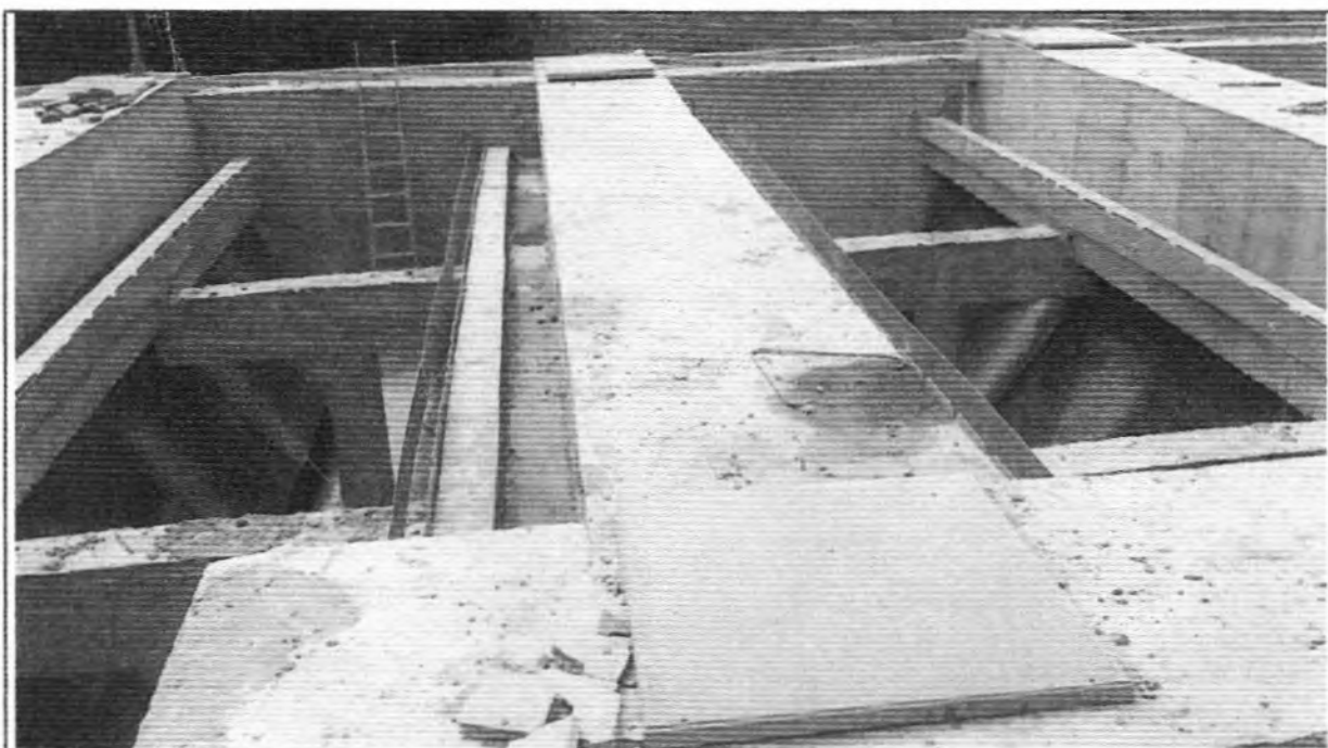
Descrição: Instalação das tampas de fibra do Reator 2.
