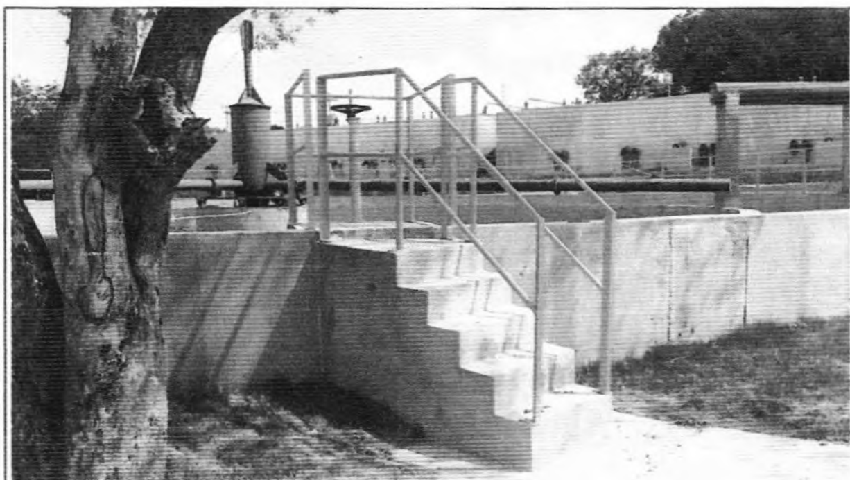
Descrição: Instalação do guarda corpo na escada do Filtro 1.
