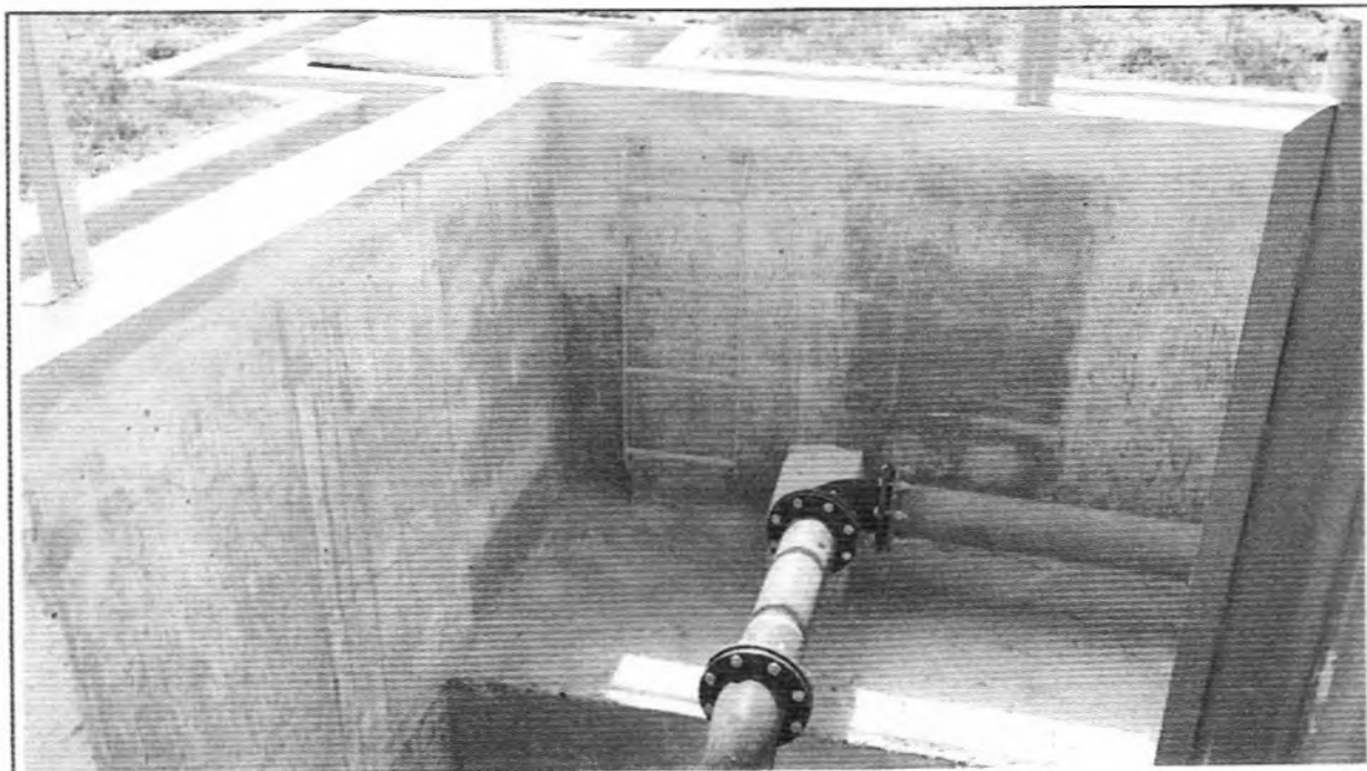
Descrição: Instalação da escada marinheiro do barrilete da EE de Recirculação.
