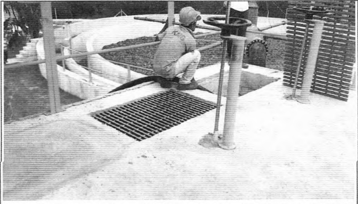
Descrição: Enchimento da Caixa de Fluxo 2 para teste a fria do Filtro 1.
