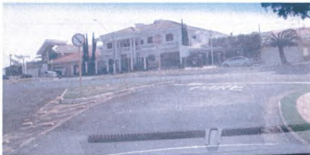
7. Localização: cruzamento da Rua Emílio Menon com Avenida Mario da Silva Camar Cenário: Placa sinalização vertical de regulamentação R-24b (passagem obrigatória) corretamente posicionada, porém a placa de regulamentação R-1 (parada obrigatória) posicionada do lado esquerdo
