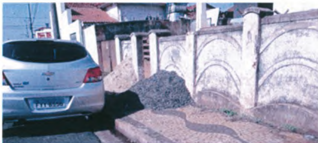
3. Localização: Cruzamento da Rua Campos Sales com a Rua Bernardino Sampaio Cenário: Calçada com largura inferior a exigida por norma, com inclinação transversal superior permitida
