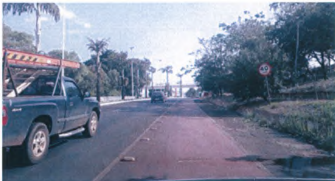
Figura 28. Formulário 8. Ciclovia existente.
