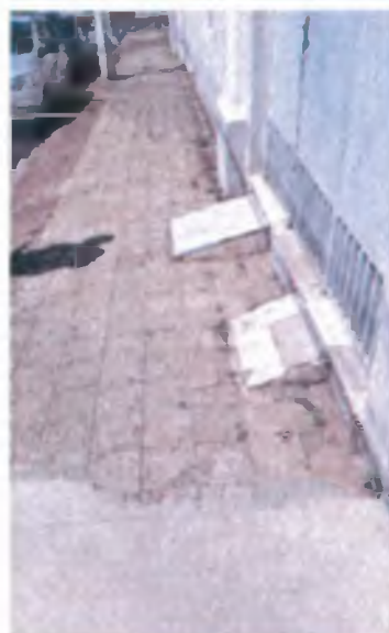
11. Localização: Rua Rui Barbosa entre as ruas Prudente de Moraes e Treze de Maio Cenário: Passeio público com largura reduzida (menor que a exigida) devido à presença de rampas de garagem
