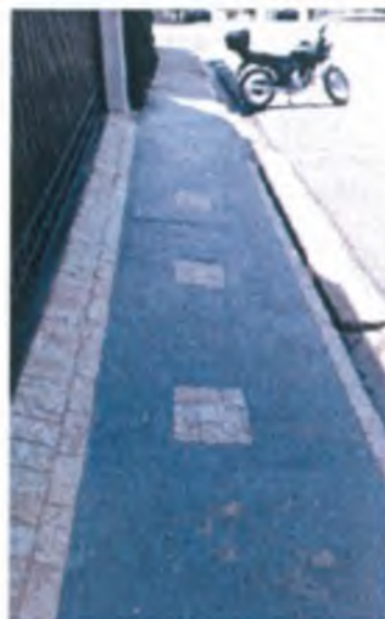
3. Localização: Cruzamento da Rua Campos Sales com a Rua Bernardino Sampaio Cenário: Calçada com largura inferior a exigida por norma, com inclinação transversal superior permitida
