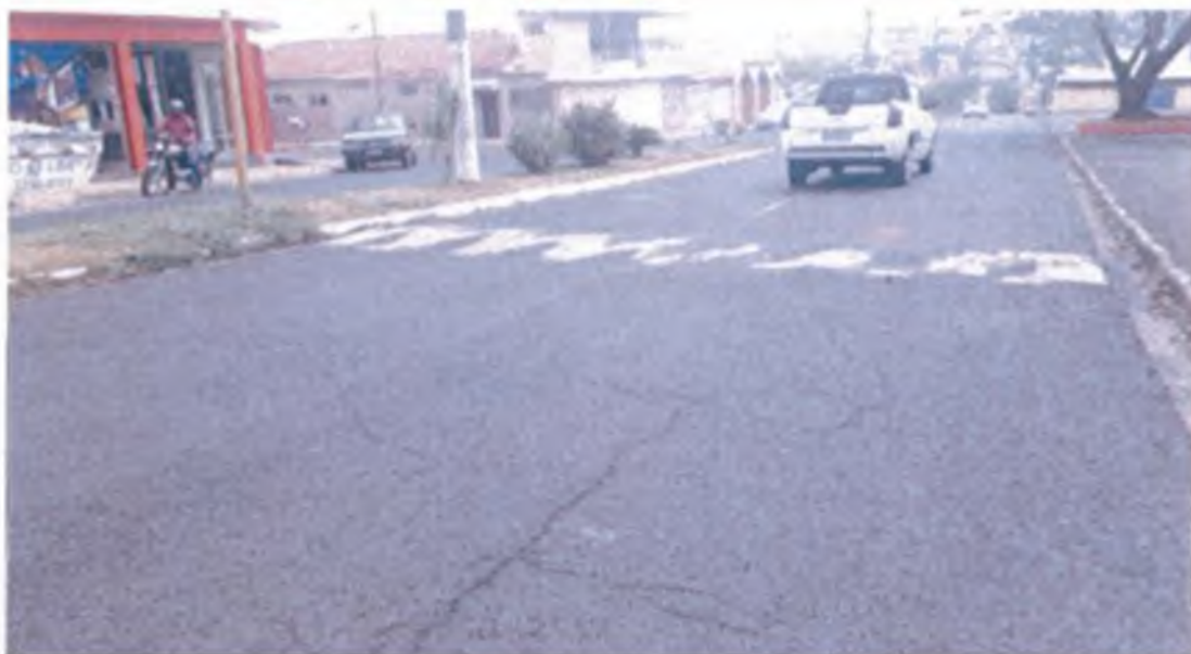
5. Localização: Avenida João Perissinotti em frente ao Ginásio de Esportes Antônio D' Ambrósio Cenário: Pintura de lombada em desacordo com o padrão exigido
