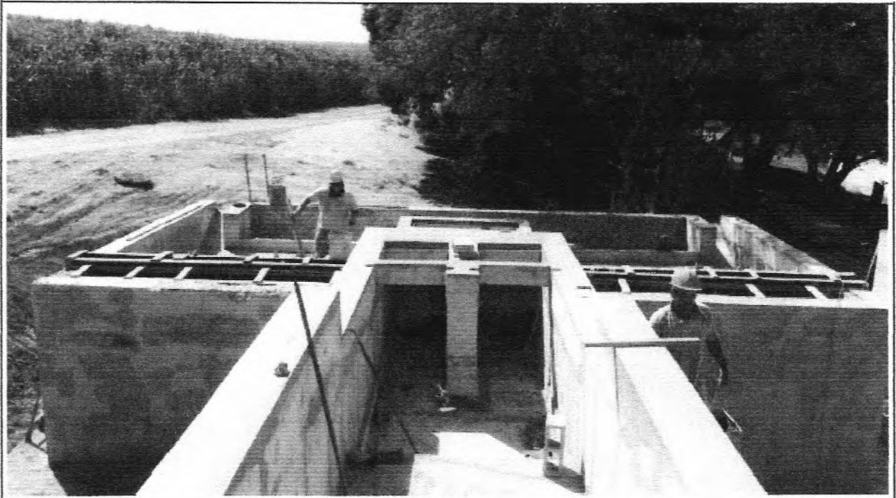
**Descrição:** Desarenador – Regularização e acabamento das paredes
