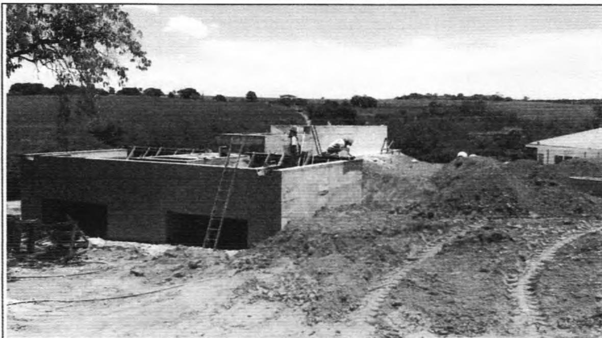
**Descrição:** Desarenador – Acabamento das paredes e Reaterro.
