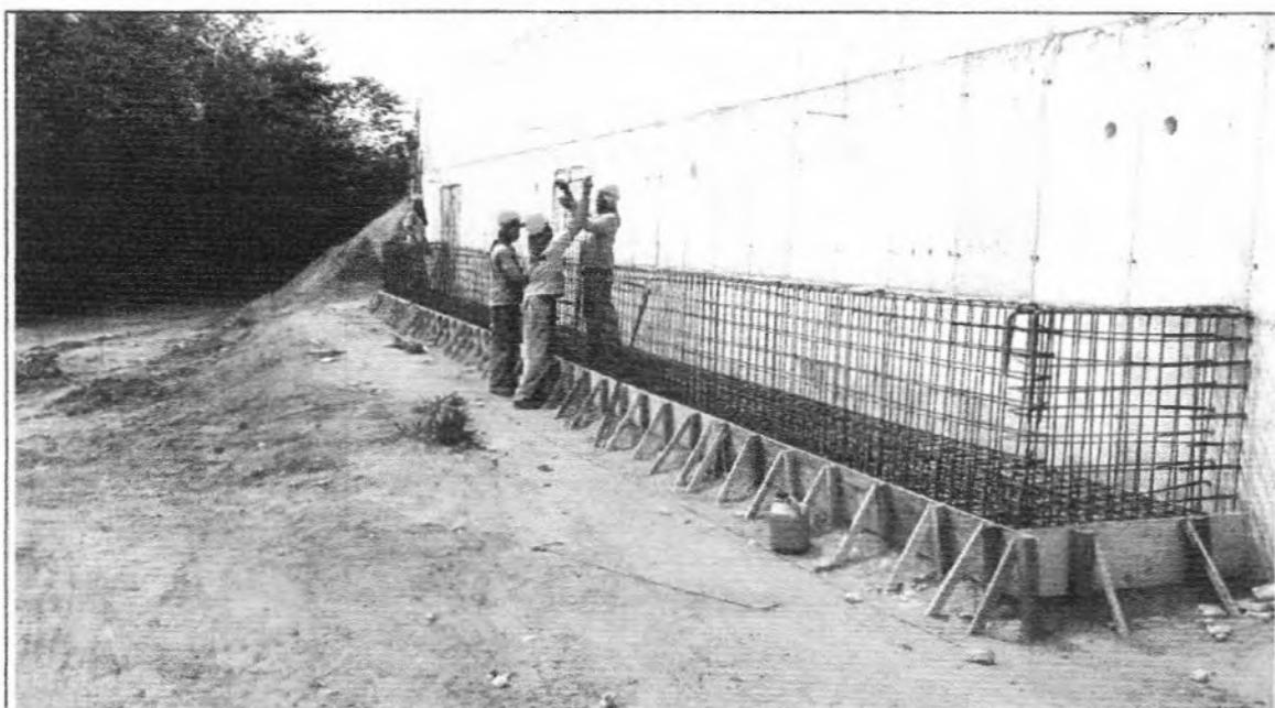
Descrição: Armadura da caixa de espuma Reator 1.
