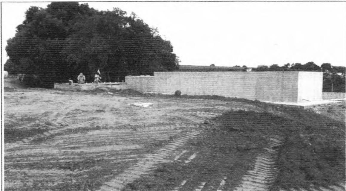
**Descrição:** Reaterro entorno do Gradeamento / Desarenador.
