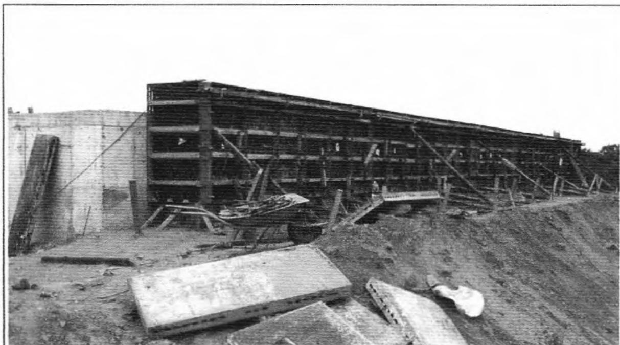
**Descrição:** Montagem das formas das paredes da canaleta do Reator 1.
