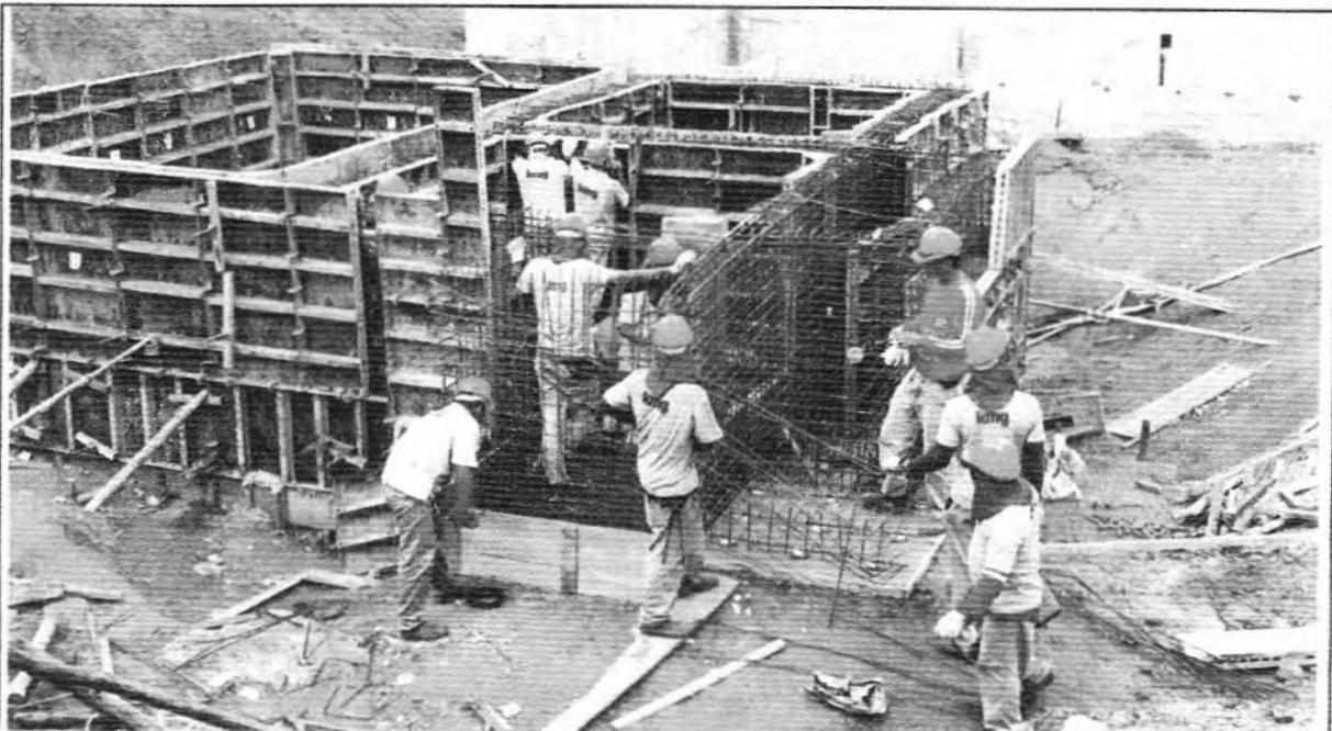
**Descrição:** Colocação das armaduras da câmara de chegada do efluente da EE Recirculação.
