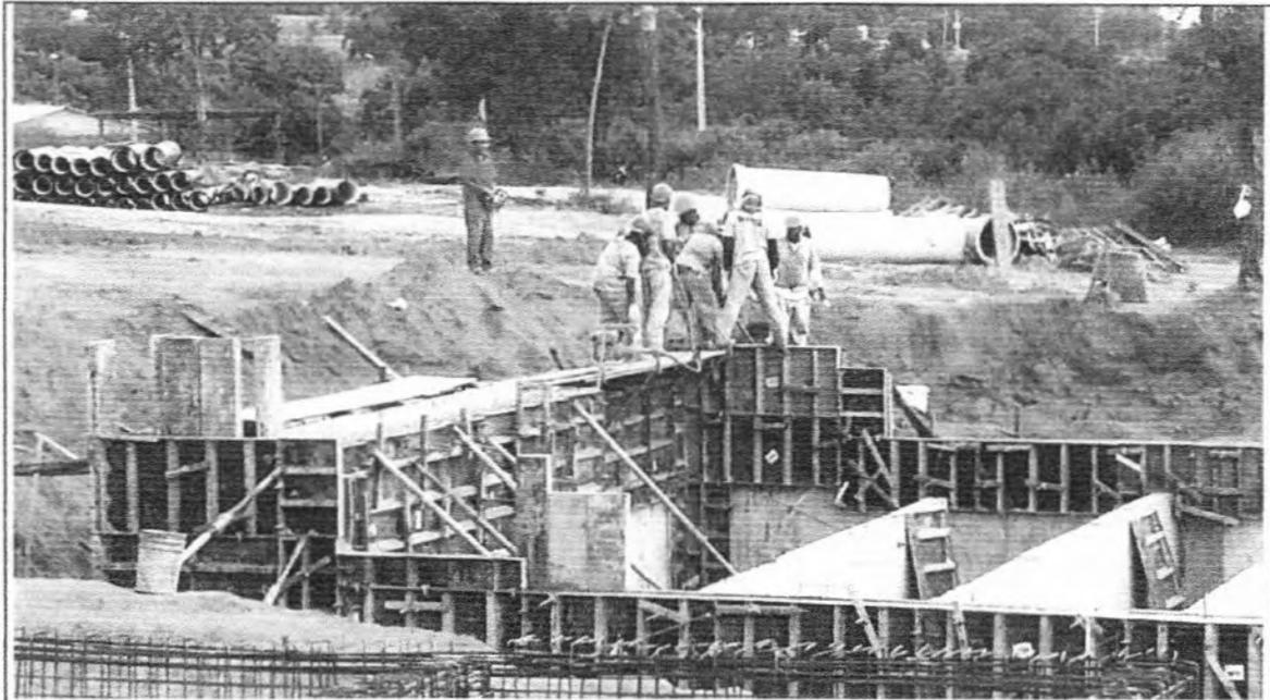
**Descrição:** Concretagem do ultimo lance de paredes do Tanque de Contato.
