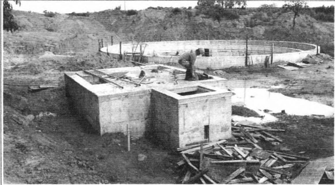
**Descrição:** Limpeza e desforma do Caixa de Fluxo 3.
