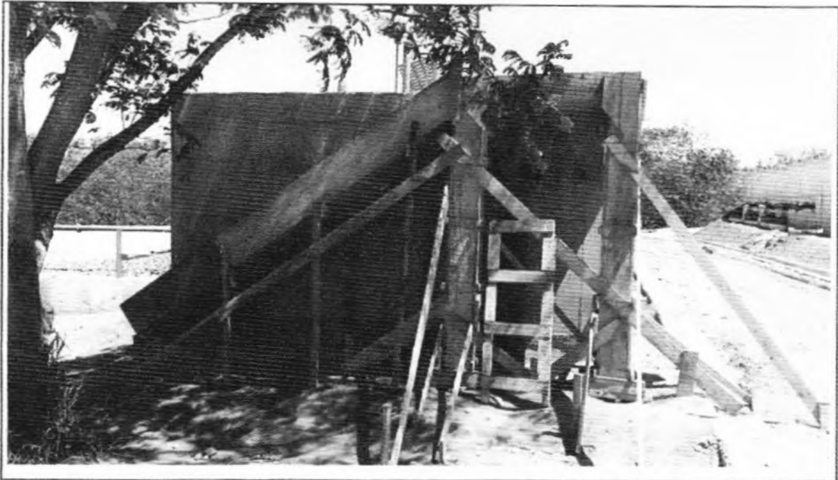
Descrição: Montagem de armadura e forma da escada da Caixa de Fluxo 2.
