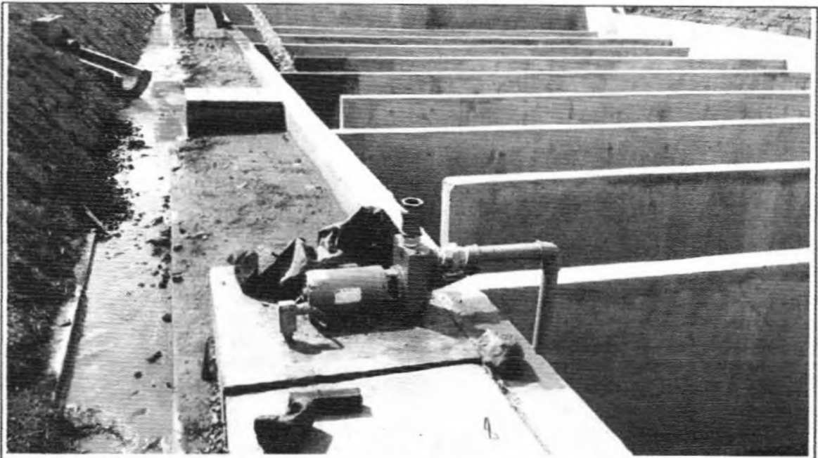
Descrição: Instalação da bomba da água de reúso do Tanque de Contato. Foto: 01 Data: 07/11/14 Arquivo: 102121
