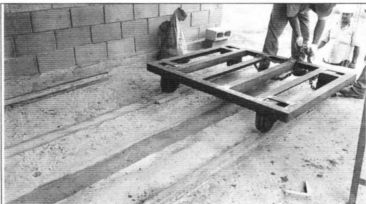
**Descrição:** Chumbamento do trilho do carrinho plataforma de auxílio para retirada da caçamba de resíduos da Centrífuga da Casa Desidratação de Lodo.
