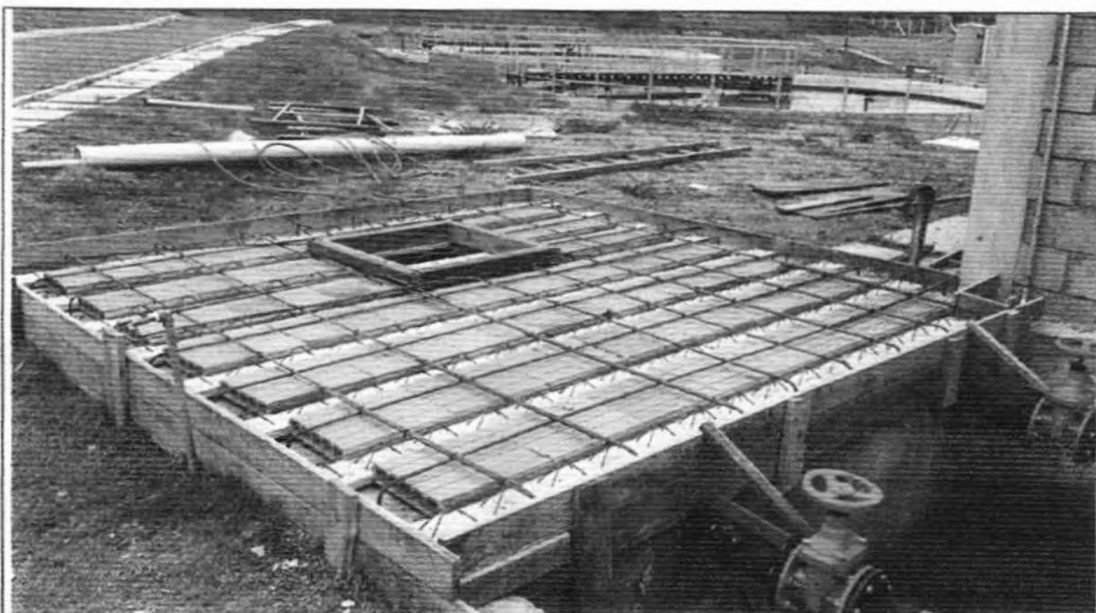
**Descrição:** Montagem de forma e armadura da laje superior do poço úmido da EE de Lodo.
