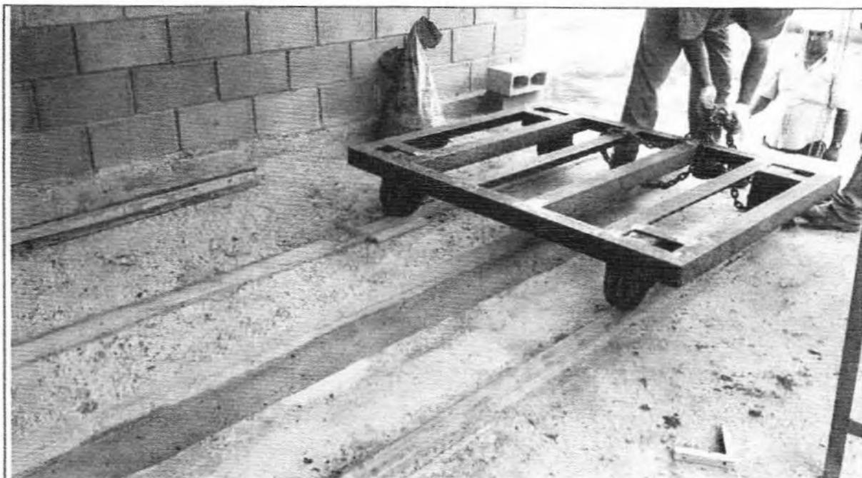
**Descrição:** Chumbamento do trilho do carrinho plataforma de auxílio para retirada da caçamba de resíduos da centrifuga da Casa Desidratação de Lodo.
