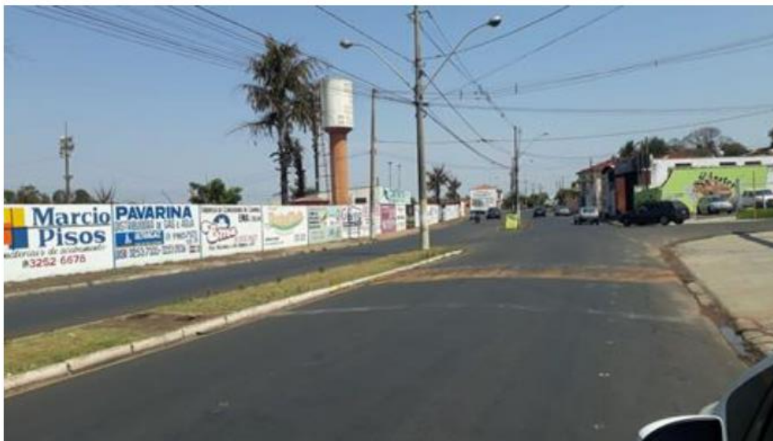
3.Localização: cruzamento da Avenida Vicente José Parise com Rua Visconde do Rio Branco Cenário: Lombada sem placa de sinalização vertical de advertência
