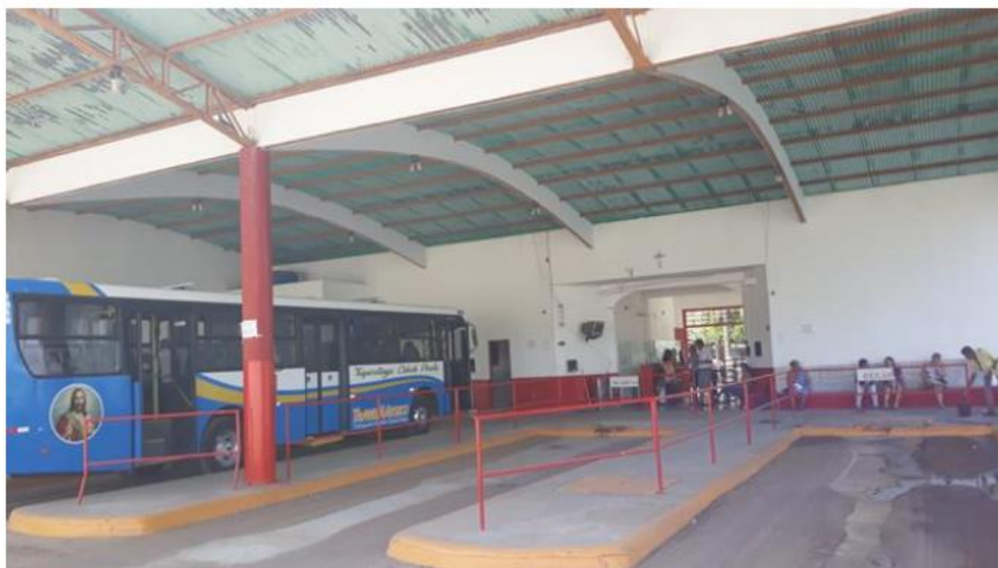
Localização: Terminal Rodoviário de Taquaritinga
