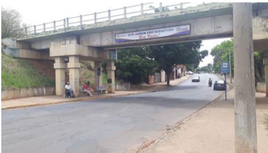
Localização: Rua Otávio Cavalcanti Martineli Cenário: Viaduto para transposição de via e passagem da ferrovia
