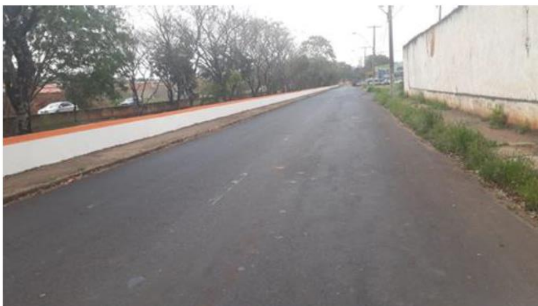
6. Localização: Avenida Vicente José Parise Cenário: Pintura de canalização e balizamento de fluxos de mesmo sentido inexistente
