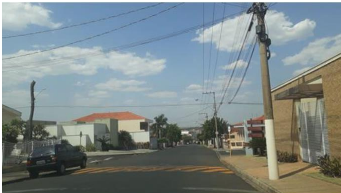
5.Localização: cruzamento da Rua Major Calderazzo com Rua Clineu B. de Magalhães Cenário: Lombada sem placa de sinalização vertical de advertência
