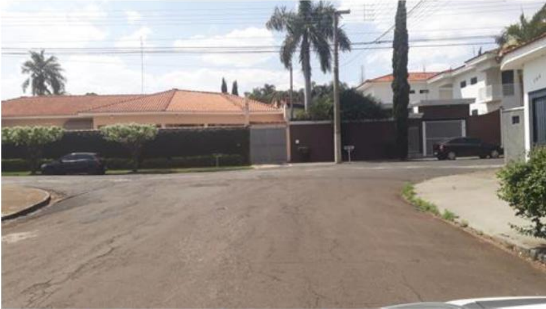
5. Localização: cruzamento da Rua Anselmo Magnani com Rua Teófilo Rocha Cenário: Placa de sinalização vertical de regulamentação R-1 (parada obrigatória) inexistente
