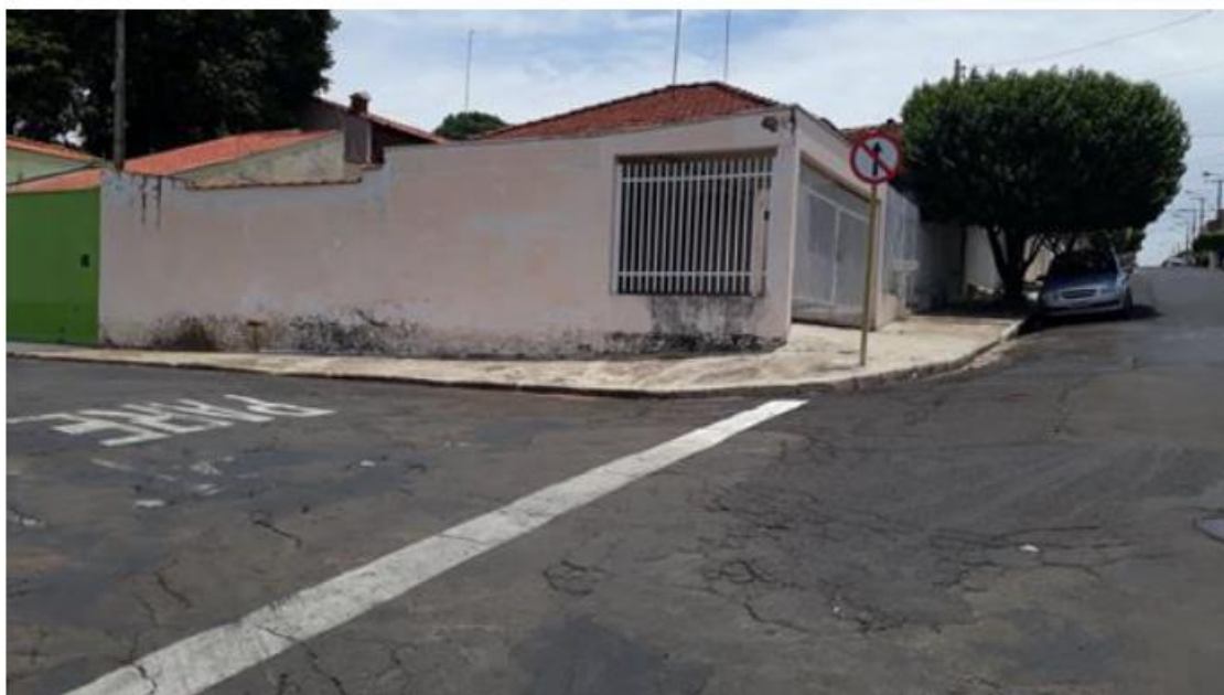
11.Localização: cruzamento da Rua Bernardino Sampaio com Rua José Bonifácio Cenário: Placa de sinalização vertical de regulamentação R-24a (sentido de circulação da via) inexistente para o motorista na posição do "PARE"
