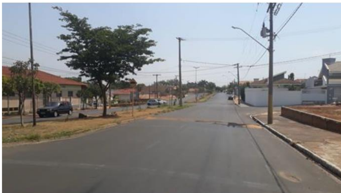
6.Localização: cruzamento da Avenida Caetano Decaro com Avenida Savério Salvagni Cenário: Lombada com placa de sinalização vertical de advertência posicionada do lado esquerdo
