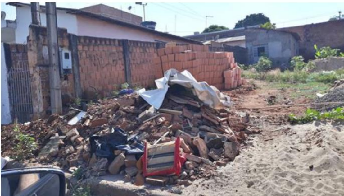
6. Localização: Rua José D' Ângelo entre as ruas Antônio D' Ambrósio e Hilanio dos Anjos Cenário: Inexistência de calçada (passeio sem pavimentação e completamente obstruído)
