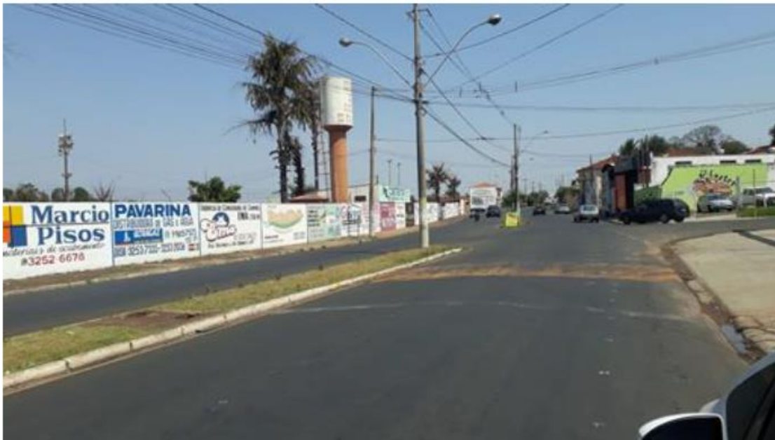
3. Localização: cruzamento da Avenida Vicente José Parise com Rua Visconde do Rio Branco Cenário: Pintura de lombada em desacordo com o padrão exigido
