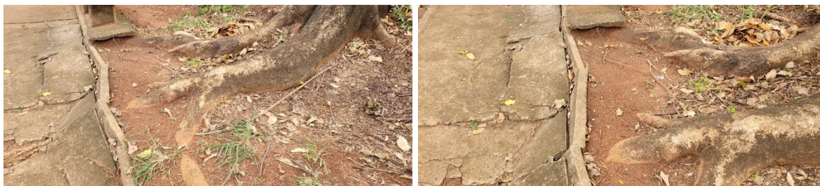
Imagens 06 a 09. Imagens referentes ao ponto de ruptura do galho e aos danos causados no passeio público devido ao desenvolvimento radicular da árvore.
