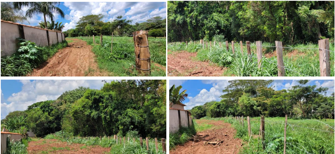
Imagens referentes à cerca, a qual compreende um total de aproximadamente 200 metros.
